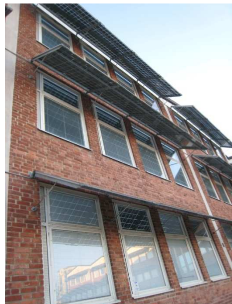
Bild 4 och 5, tillfälle 2, solstaden Malmö. Taket på Tekniska museet och Mellanhedsskolan
